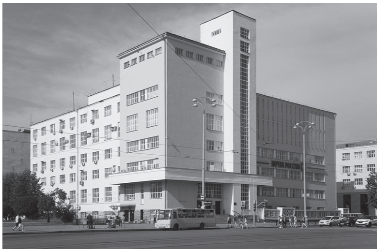
Екатеринбург, здание Почтамта
